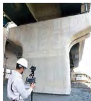
AIひび割れ解析 ソリューション
